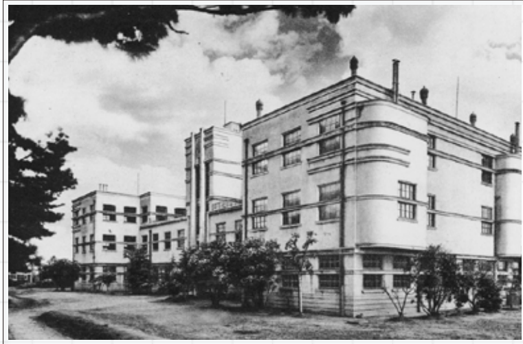
鉄筋3階建ての「牧野学舎」完成(昭和4年)
